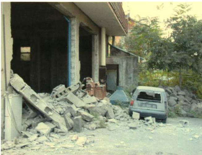
Fig. 14 - Crollo di tramezzi di un edificio in località Felicetto
