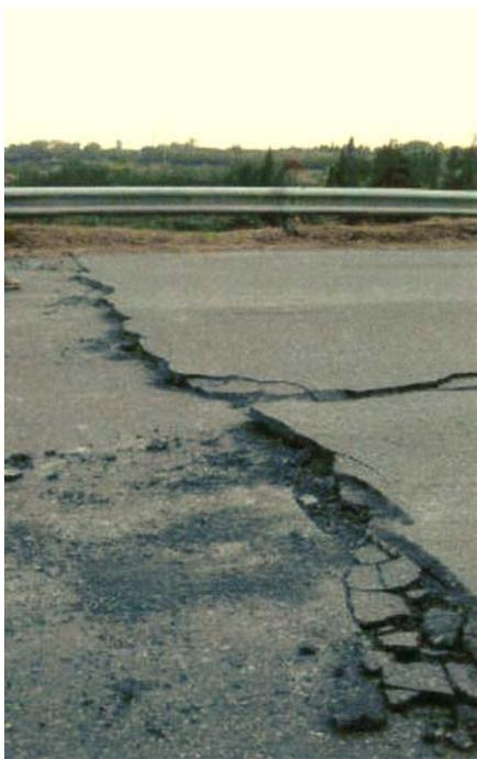
Fig. 12 - Effetti di fratture al suolo lungo una strada che attraversa una struttura
