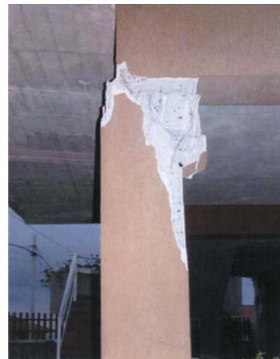
Fig. 15 - Rottura di pilastri di un edificio in località Bongiardo
